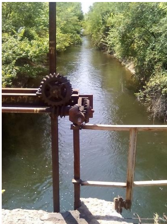
Фигура 1. Водоразпределително съоръжение с амортизиран регулиращ механизъм
